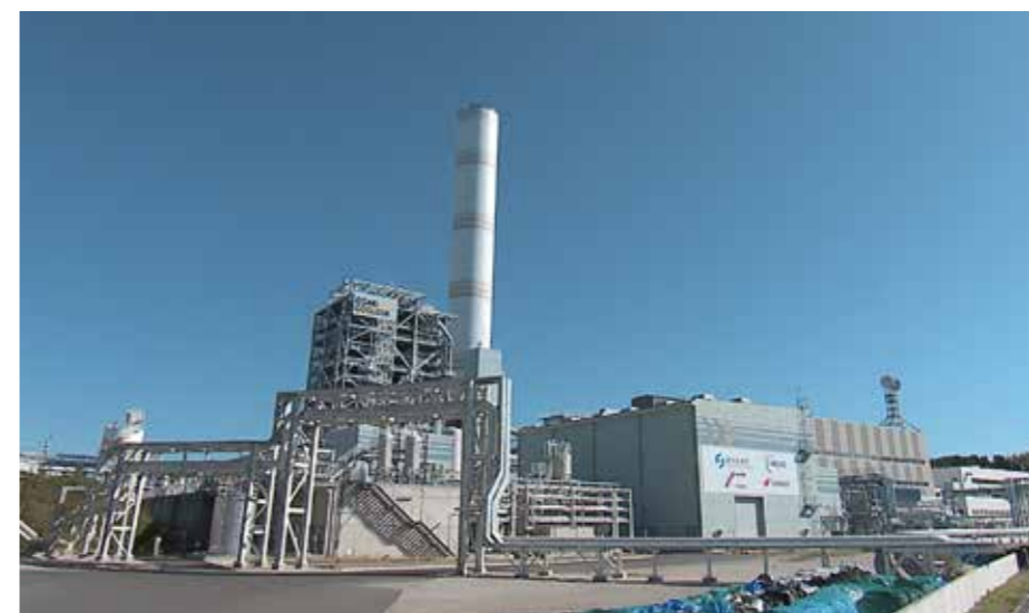
大崎クールジェンIGCC実験棟
